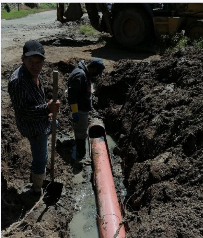
Reparación de línea de drenaje colapsada en la calle Herrera y Cairo frente al Conalep en la comunidad de Tateposco.
