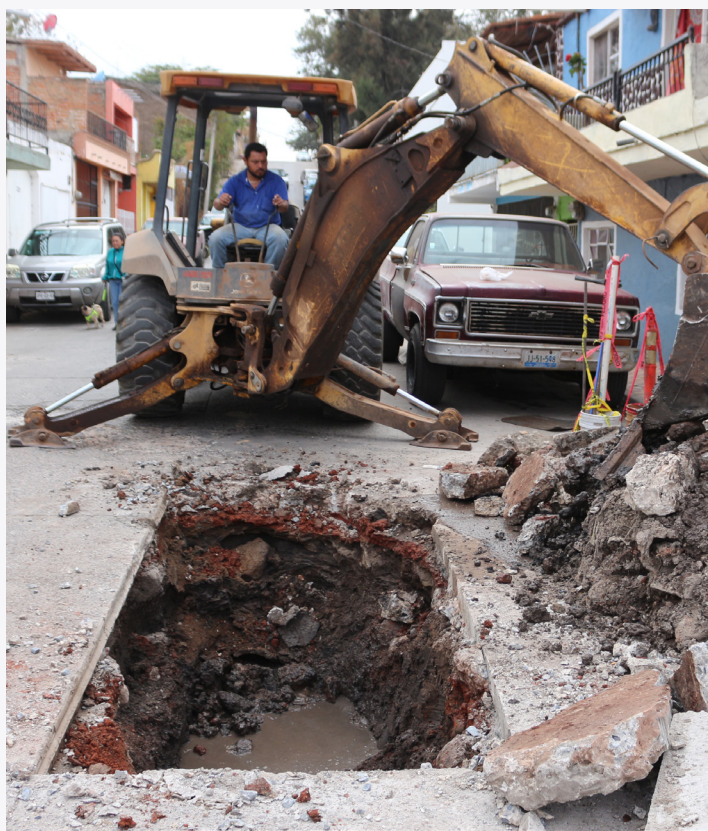
Reparación de línea de drenaje colapsada en la calle Progreso frente al DIF en la comunidad La Playa.
