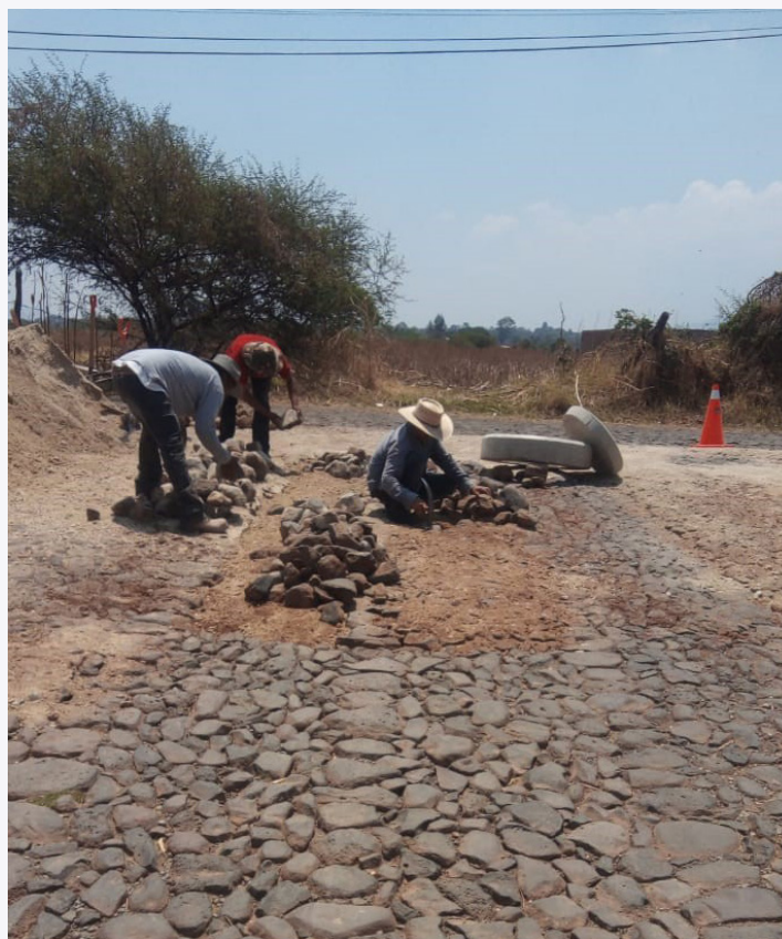
Bacheo y limpieza del camino El Bajío y calle Hidalgo en San Antonio Juanacaxtle en el municipio de Juanacatlan.
