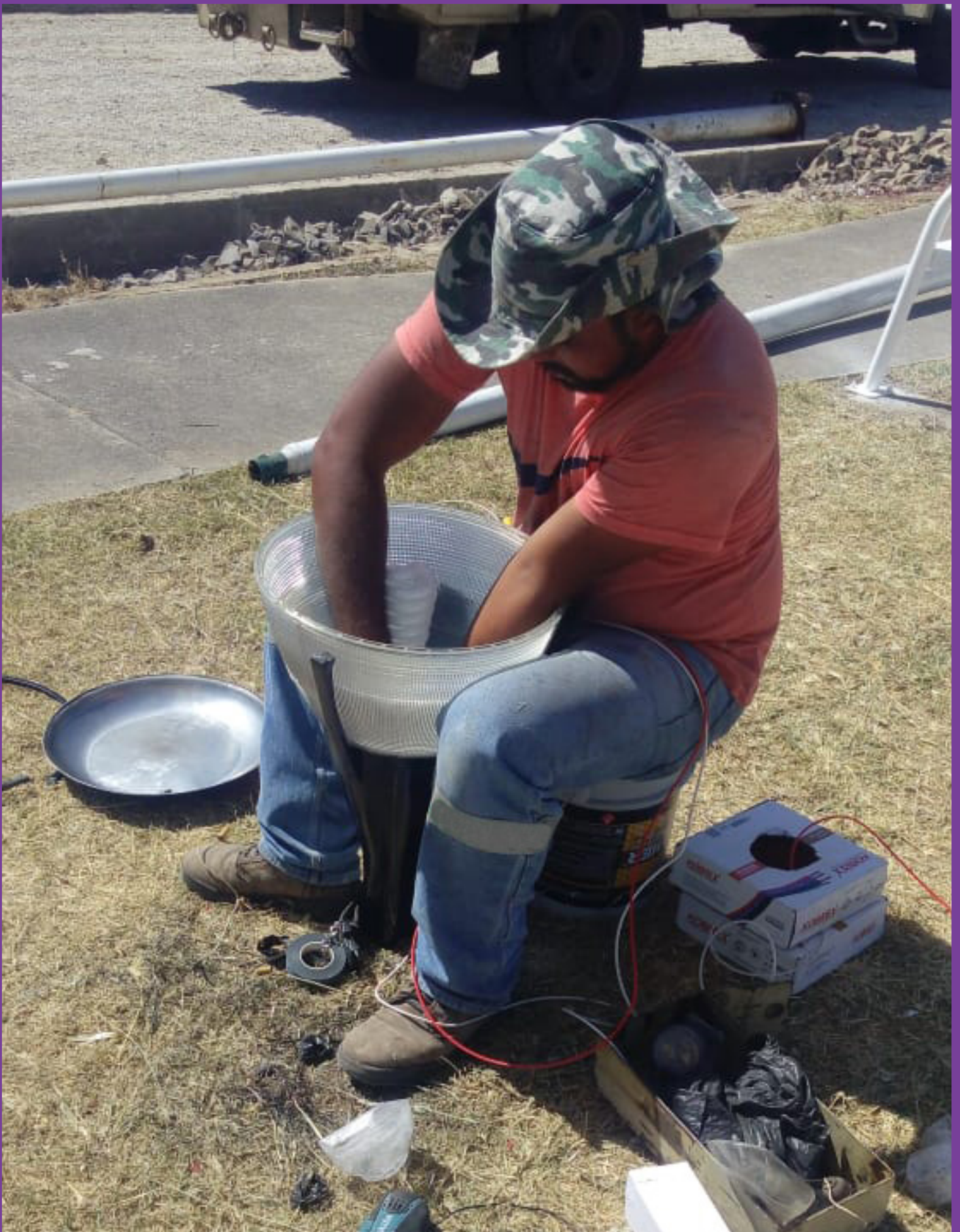
Rehabilitación de luminarias
