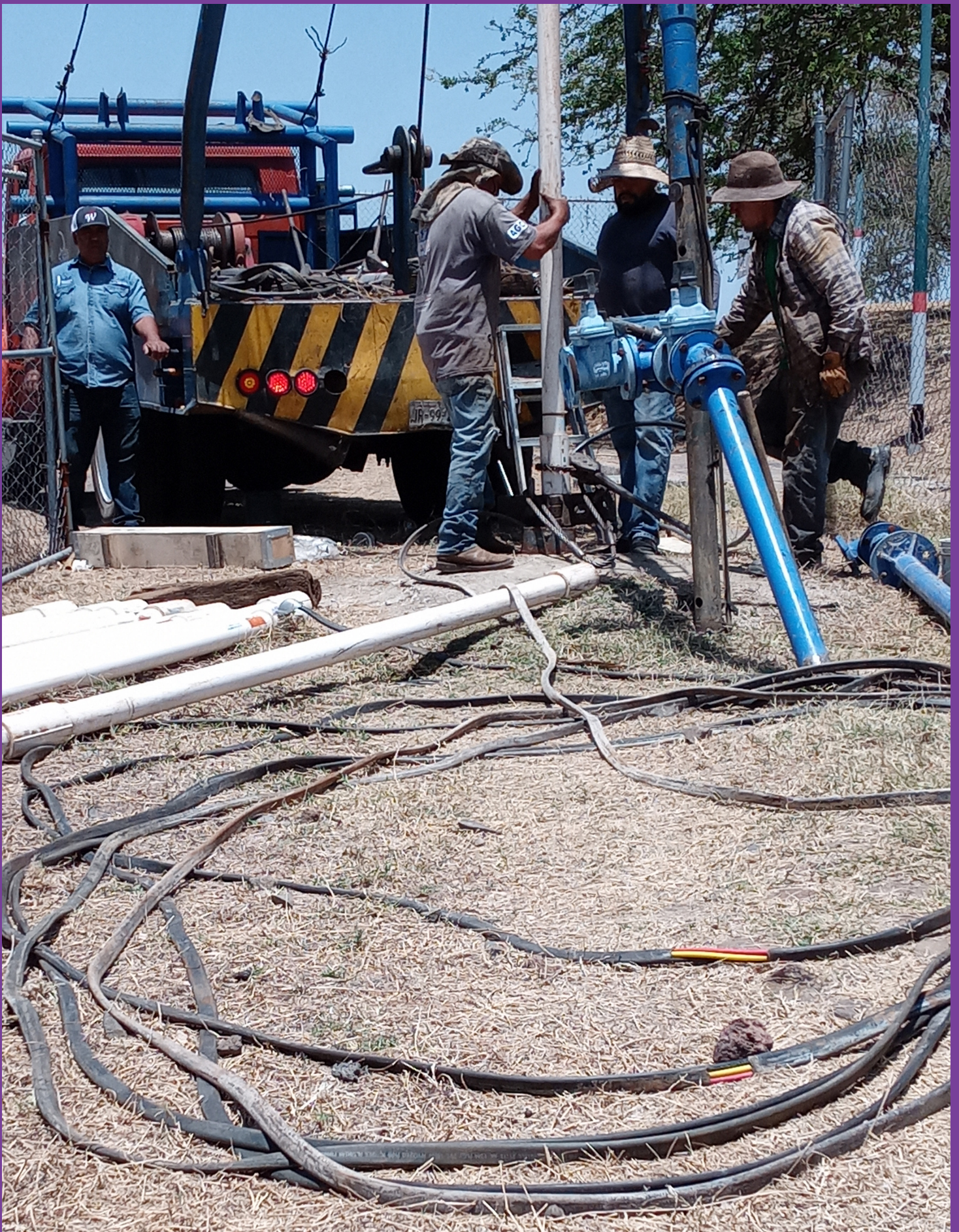
Trabajos en pozo de agua potable
