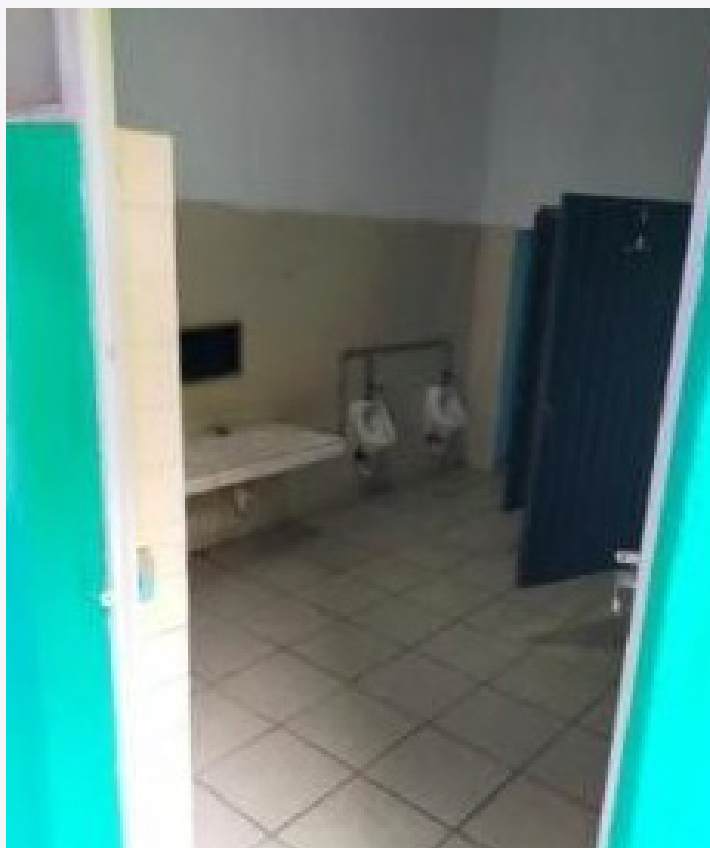
Instalación de piso y azulejo en baño de niños del Preescolar Juan Escutia
